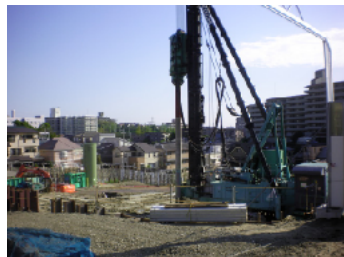
③ グラブアーキス千里山玄関前道路に面したゲートからA敷地方面の写真。重機は60トンラフターと思われます。
