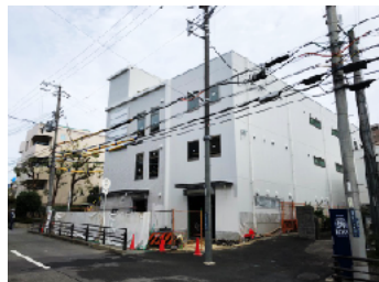
① 建設工事中の医療ビル
