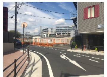
旧消防団詰所跡地
