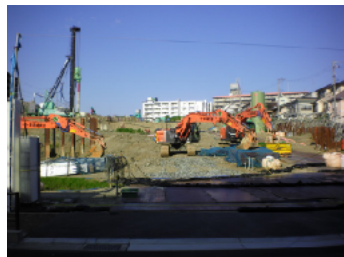
④ コンビニ向いのゲートから最上部のC敷地方面を写す。左の黒い煙突のようなものが60トンラフターと推定。
